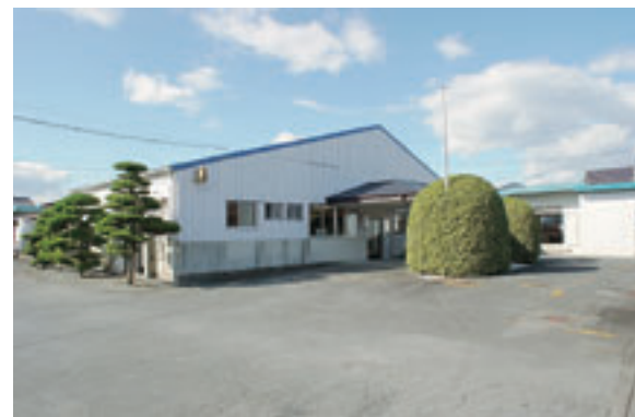
明和町斎宮……伊勢神宮近くの工場。ゆったりとした敷地内に寮もある
