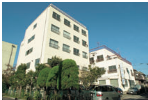
5階建てと3階建てが隣り合っている東京本社ビル。
