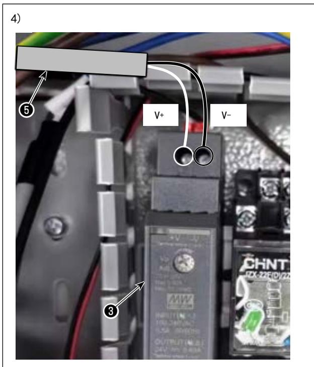
4) 请将工序④~⑧中引入电装架内部的 BK 控制箱的电源电缆⑤与 BK10\_24V\_POWER\_SUPPLY ③ 连接。
