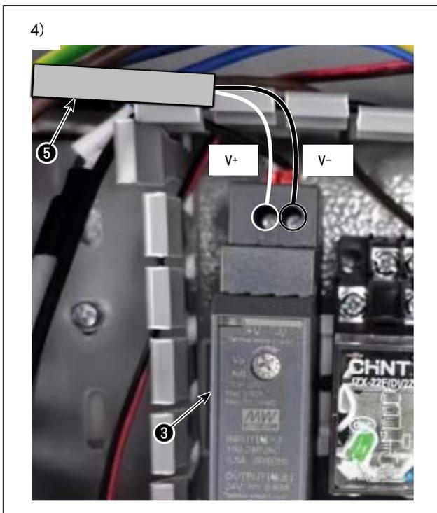
4) 请将工序④~⑦中引入电装架内部的 BK 控制箱的电源电缆⑤与 BK10\_24V\_POWER\_SUPPLY ③ 连接。
