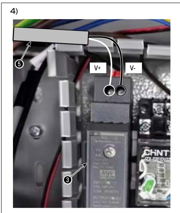
4) 工程④～⑧で電装ラック内部に引き入れた BK コントロールボックスの電源ケーブル⑤を BK10\_24V\_POWER\_SUPPLY ③と接続してください。
