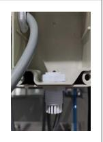
4) 将位于风机电源电线的电线密封套放入电源盒。
