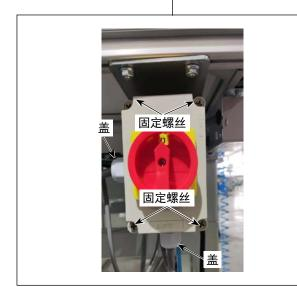
7) 从电源盒中拔出左方和下方的电线的多余部分, 将开关放入电源盒中,拧紧固定螺丝。
