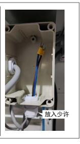
5) 将电线密封套的盖子放入电线中,让电线穿过电线密封套。 将盖子少许放入密封套。
