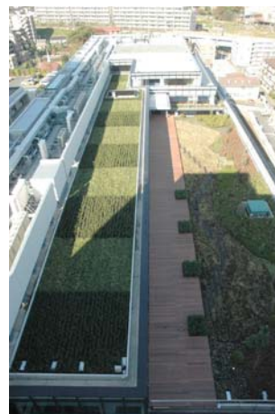
西栋的楼顶花园
